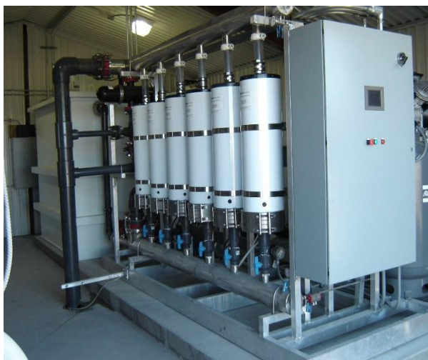
Figure 14 – Photo modules d'ultrafiltration
