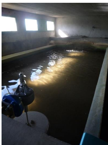
Figure 12 - Photos d'un filtre à sable
